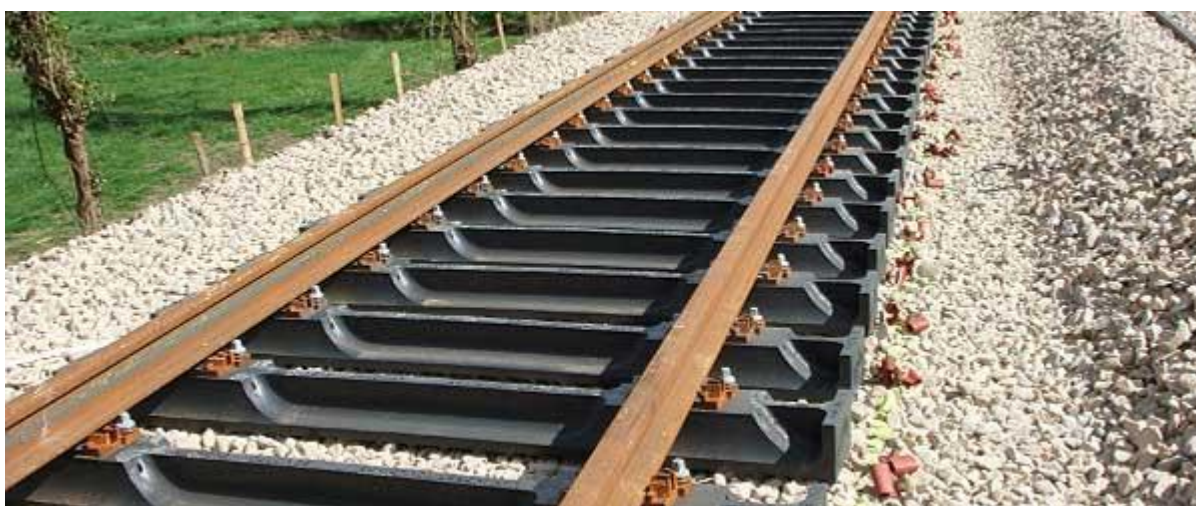
Slika 2. Tračnice s pragovima [5]
