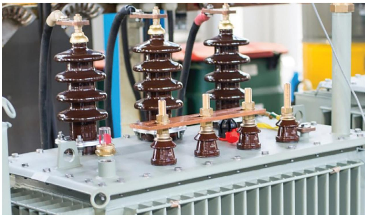
Slika 24. Priključci transformatora unutar vakuumske komore
