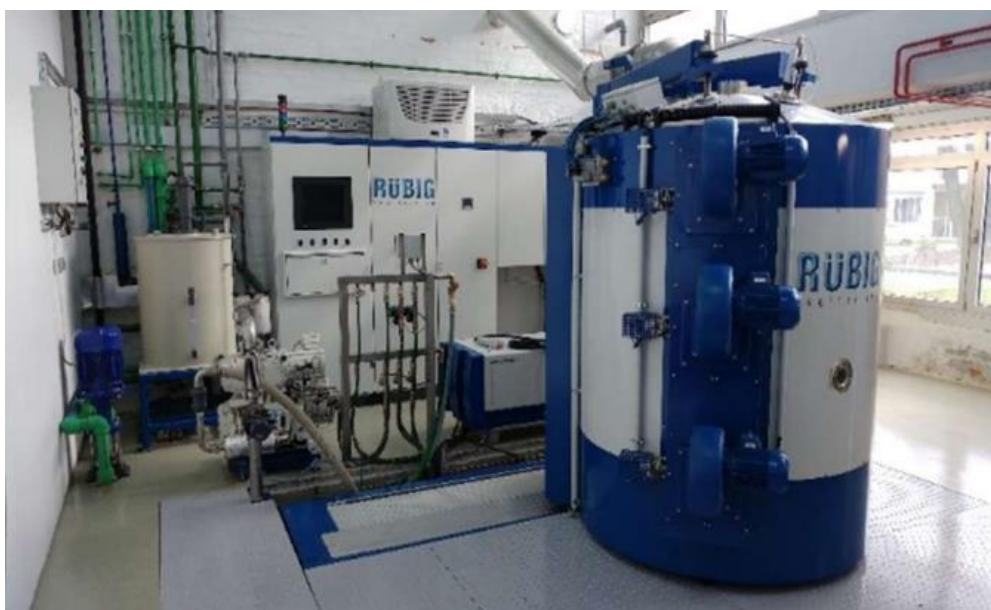
Slika 7. Uređaj za PACVD prevlačenje na FSB-u u Zagrebu
