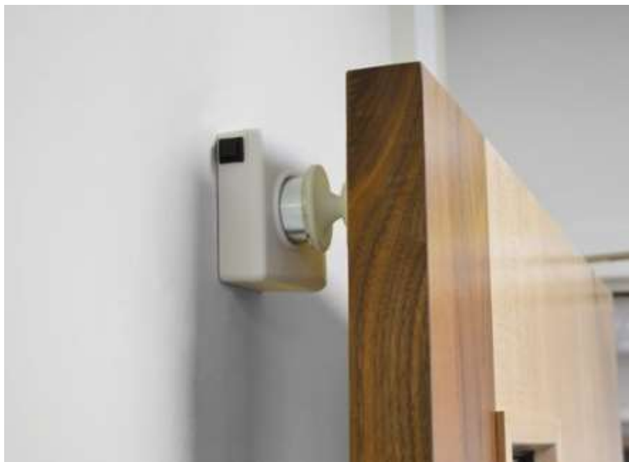
Slika 15. Elektromagnetski držač za vrata [73]
