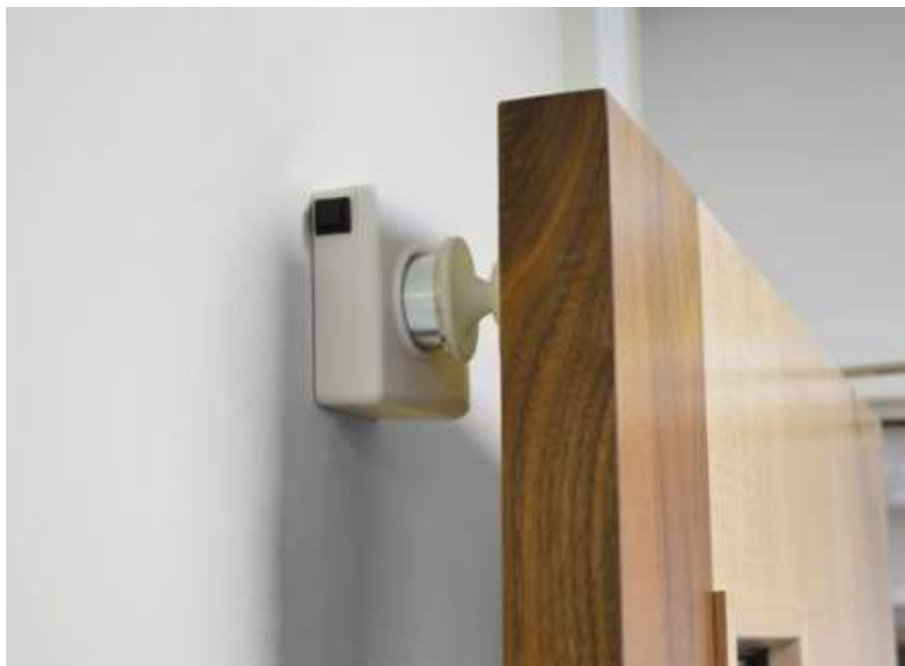
Slika 15. Elektromagnetski držač za vrata [73]
