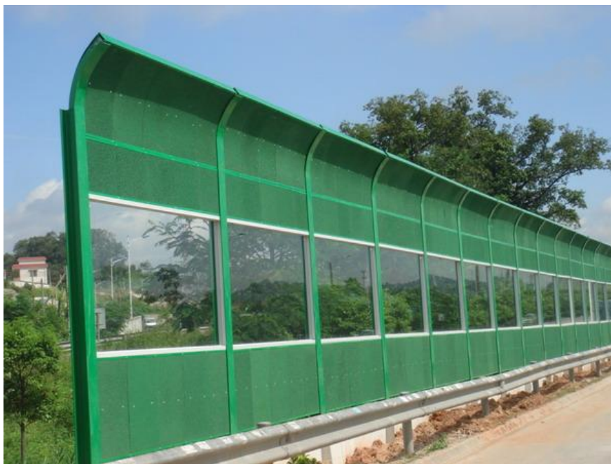
Slika 36 – Aluminijske pjene za apsorpciju zvuka, obojane otpornije na koroziju [12]
