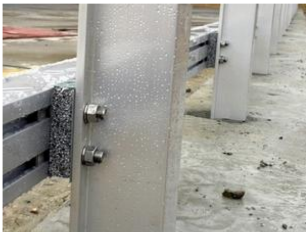
Slika 32 – Primjena aluminijske pjene kao elemenata za apsorpciju energije [12]
