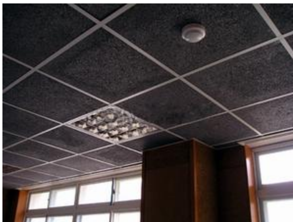
Slika 41 – Primjena aluminijskih pjena u zgradama [12]
