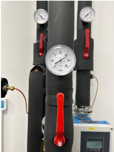
Slika 9. Temperature sonde uronjene u čahure
