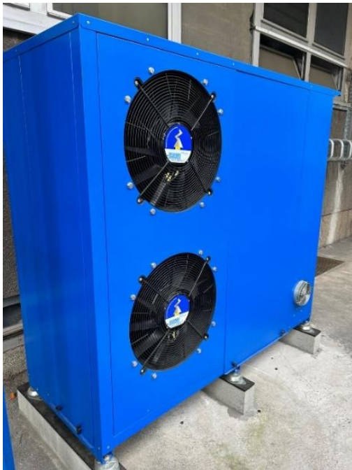
Slika 5. Vanjska jedinice dizalice topline
