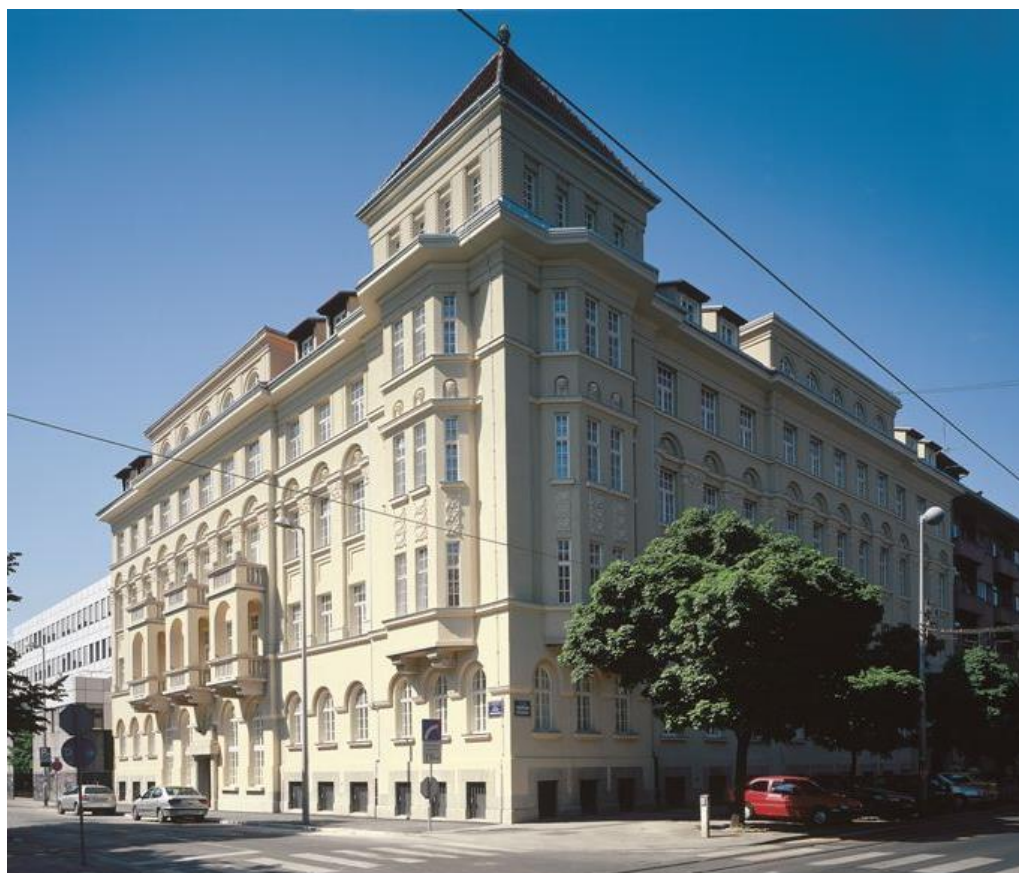
Slika 1. Sjeverno i istočno pročelje zgrade Ministarstva kulture u Zagrebu [3]
