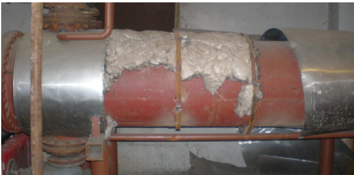
Slika 10. Izmjenjivač topline u podsustavu proizvodnje
