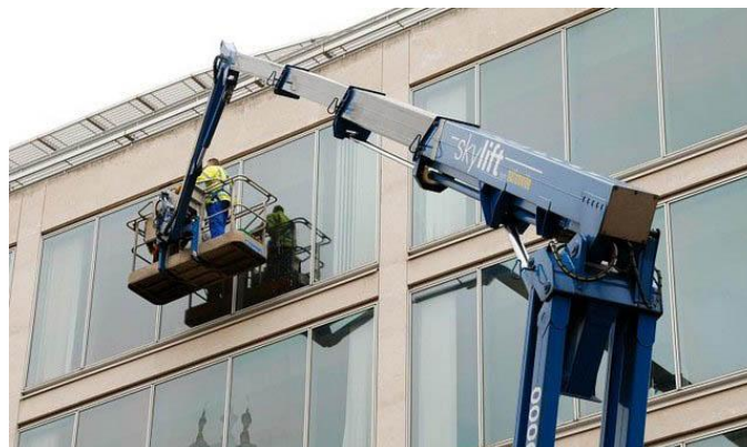
Slika 1.4 Čišćenje prozora uz pomoć teleskopske platforme [6]
