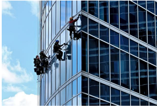
Slika 1.2 Čišćenje prozora s pristupom pomoću užeta [4]
