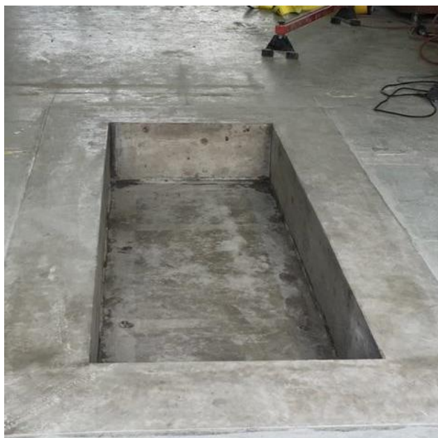
Slika 10. Primjer ugradbenog bazena za ukopanu podiznu platformu
