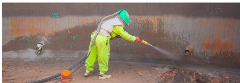
Slika 17. Čišćenje mokrim mlazom abraziva [36]
