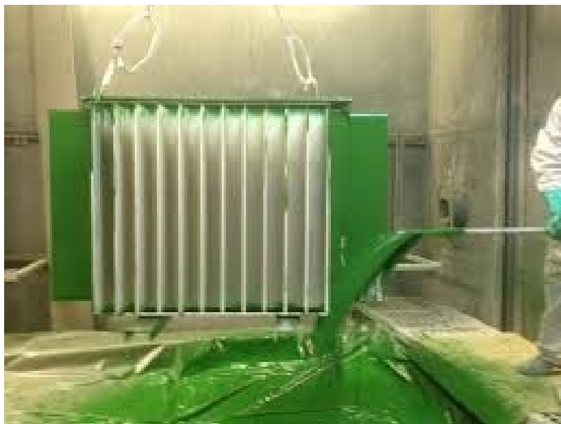
Slika 21. Postupak prelijevanja dijela transformatora [40]
