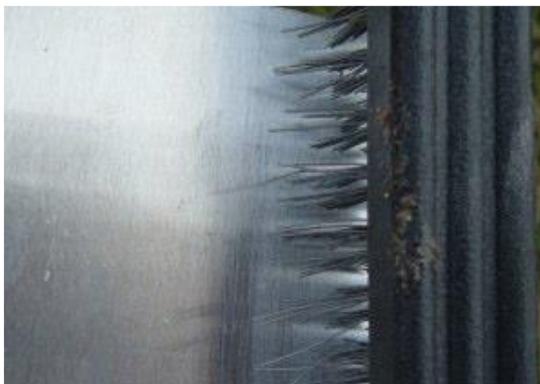
Slika 22. Očišćena površina gdje će se zavarivati [21]
