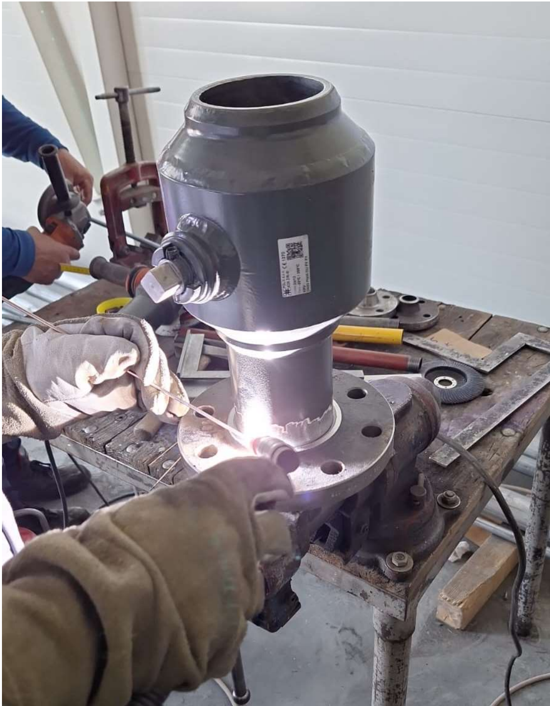
Slika 22. Zavarivanje korijenog zvara
