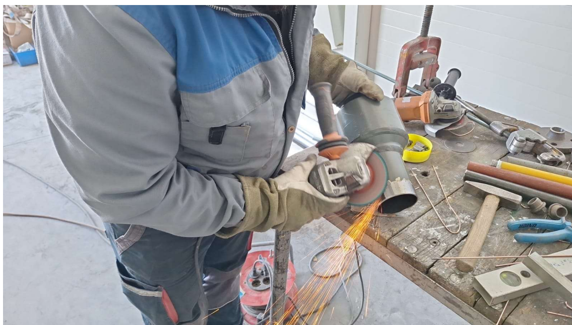
Slika 19. Priprema tijela ventila za zavarivanje
