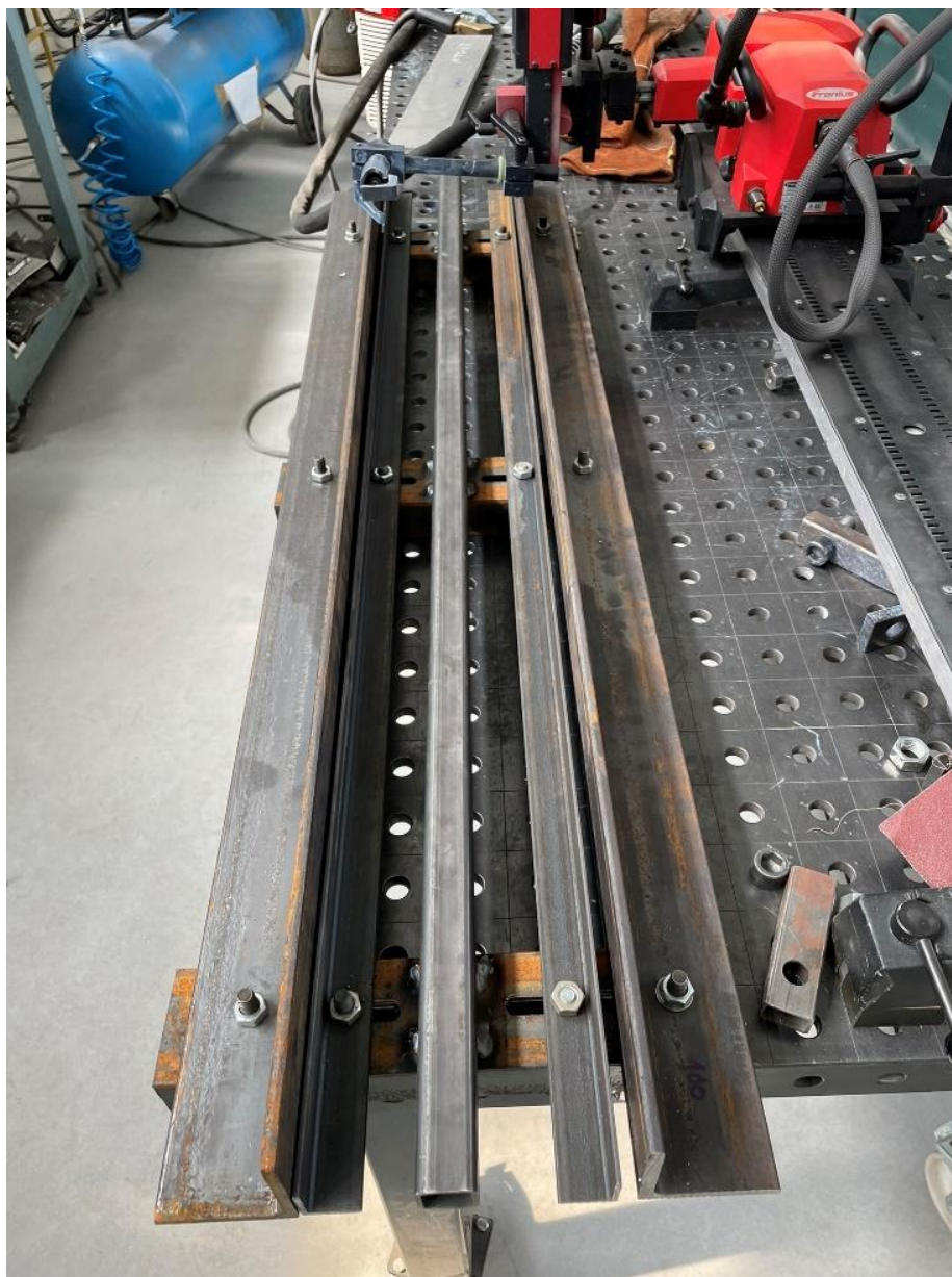
Slika 39. Naprava za stezanje pripremljena za zavarivanje
