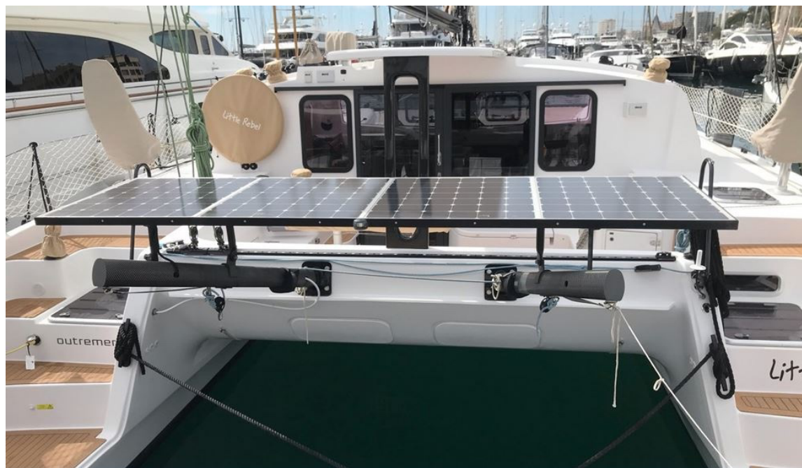
Slika 4. Montaža solarnih panela na krmu katamarana [6]
