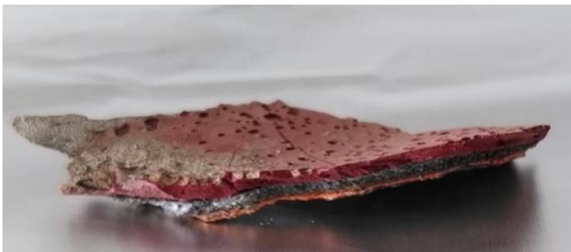
Slika 2. Dio sustava premaza odlomljen s konstrukcije [3]
