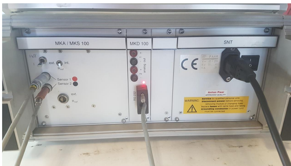
Slika 18: Most - pogled straga
