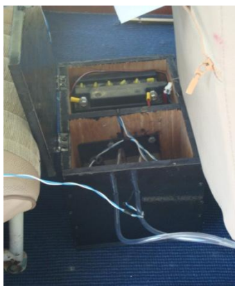
Slika 5.2 Oprema potrebna za mjerenje, nakon montaže u zrakoplovu
