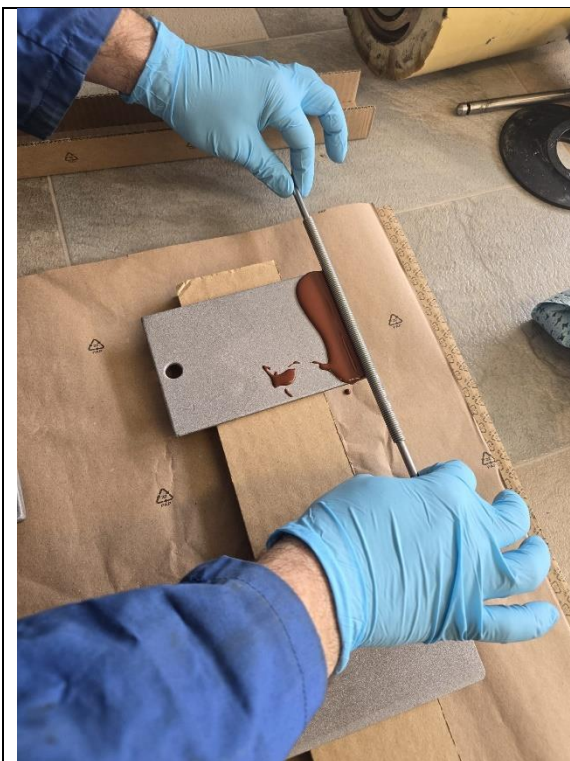
Slika 22 Nanošenje Helios temeljnog premaza
