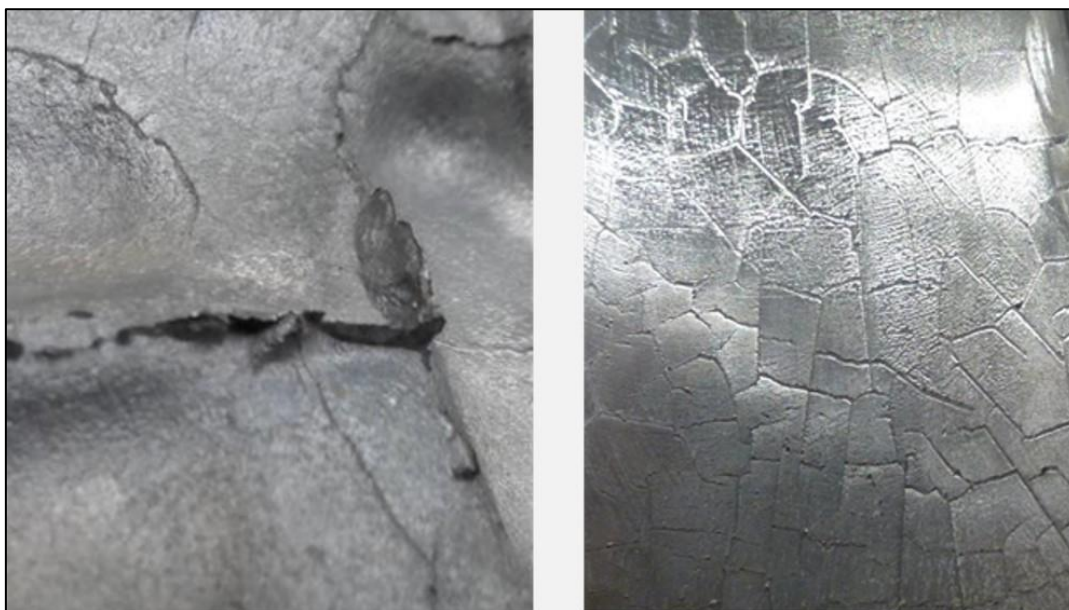
Slika 26 Pukotine na kalupu
