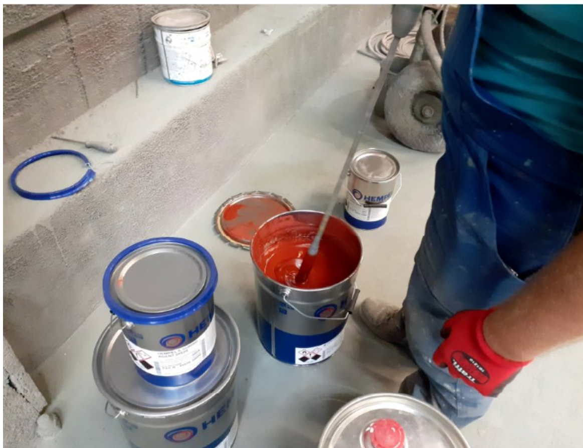
Slika 36. Miješanje temeljnog premaza
