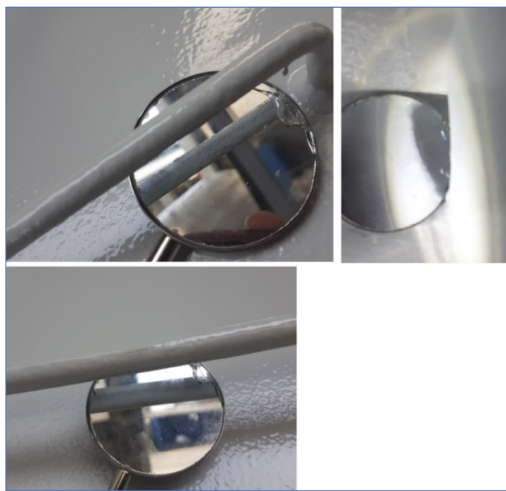
Slika 51. Nezatvoren film na nepristupačnim mjestima
