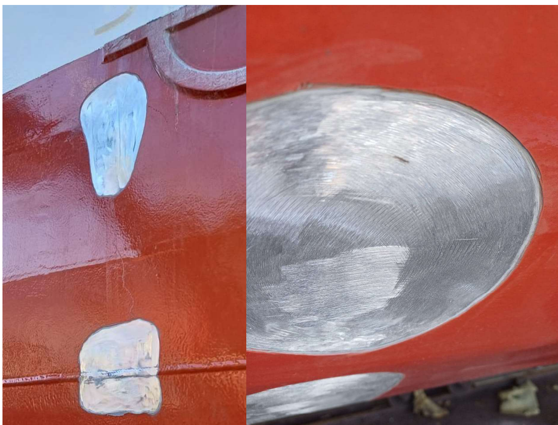
Slika 20. Priprema površine za lokalno obnavljanje silikonskog premaza
