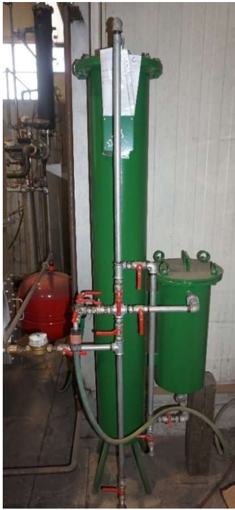
Slika 20. Ionski omekšivač
