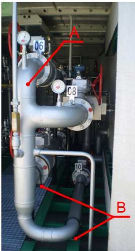
Slika 44. Pogled sa prednjih vrata na mjernu i redukcijsku liniju MRS-a
