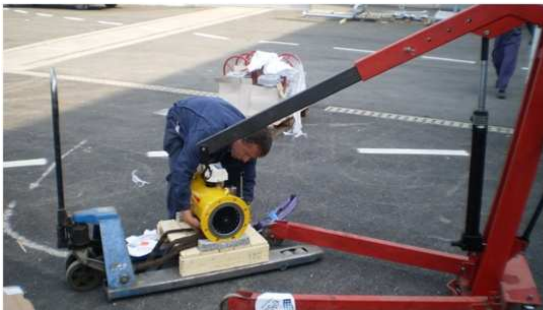
Slika 45. Priprema opreme za podizanje hidrauličnom dizalicom
