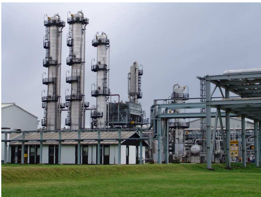
Slika 6. Centralna plinska stanica Molve
