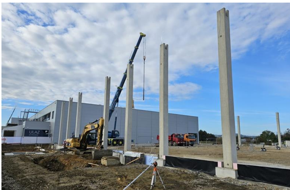
Slika 24. Izgradnja nove hale
