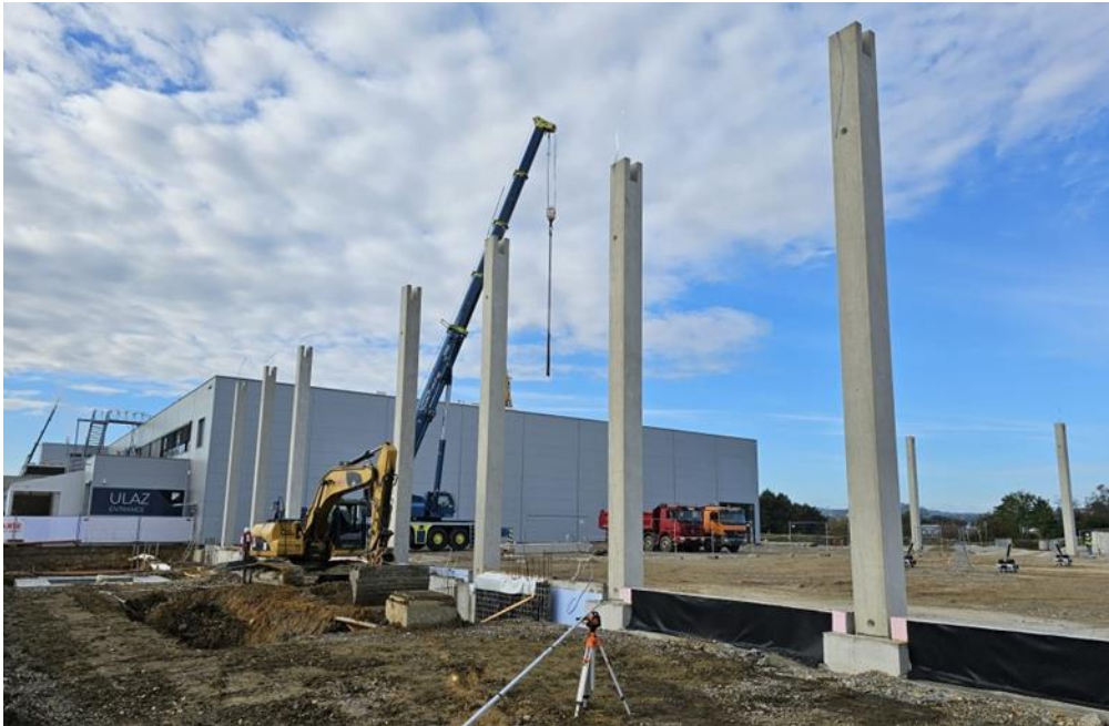
Slika 24. Izgradnja nove hale
