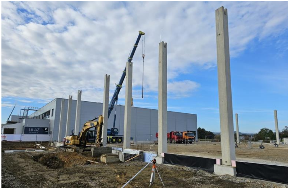
Slika 24. Izgradnja nove hale
