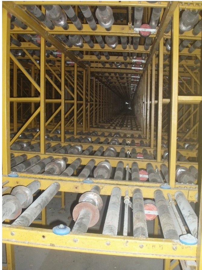
Slika 19. Tuneli u skladištu
