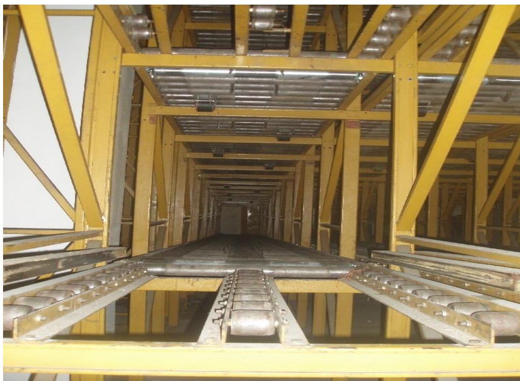
Slika 20. Tuneli valjčanih traka u skladištu
