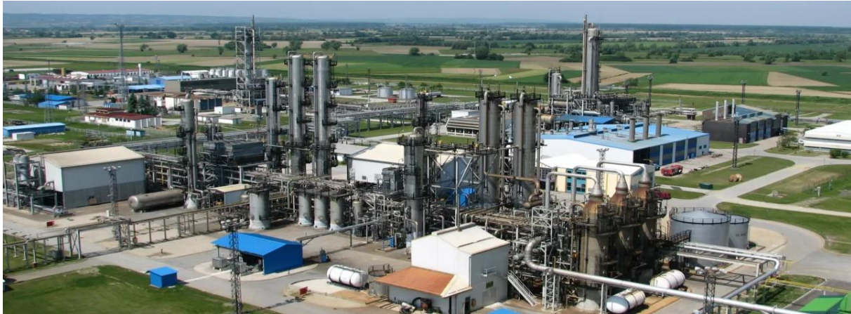
Slika 3. Postrojenja prirodnog plina [4]
