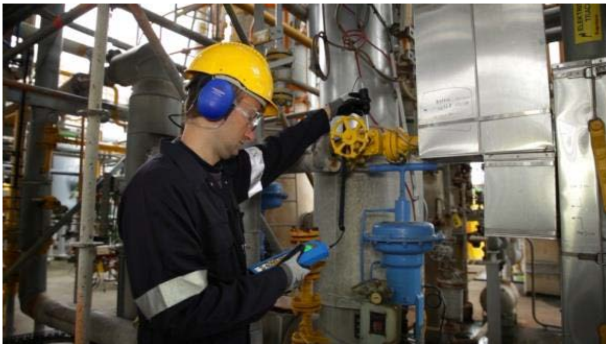
Slika 14. Prikaz ispitivanja ventila ultrazvučnom dijagnostikom [13]
