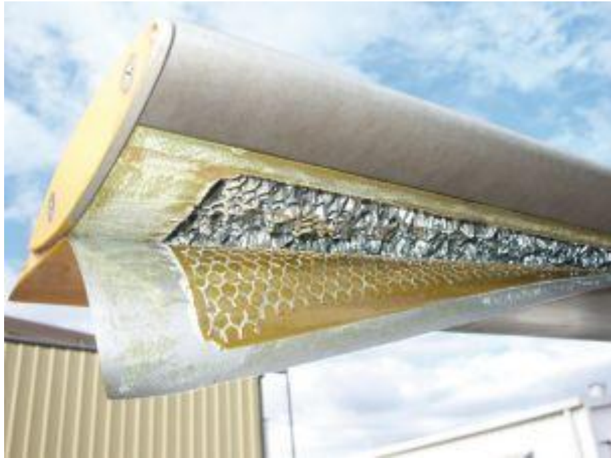
Slika 11 – Delaminacija na rotorskoj lopatici helikoptera
