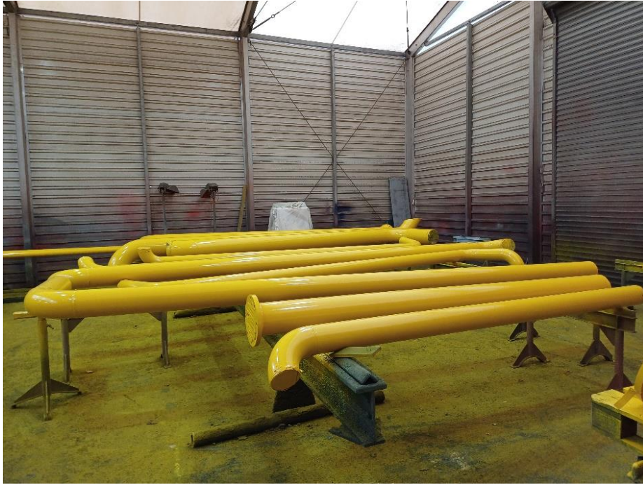
Slika 37. Cijevni elementi premazani u lakirnici
