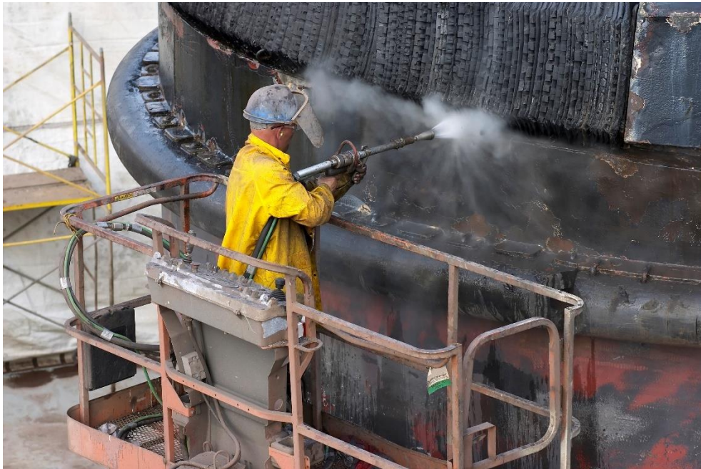
Slika 15. Priprema površine visokotlačnim vodenim mlazom [26]
