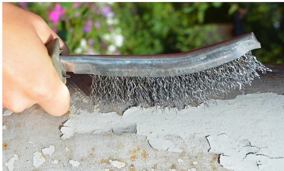
Slika 13. Čišćenje površine četkom [26]
