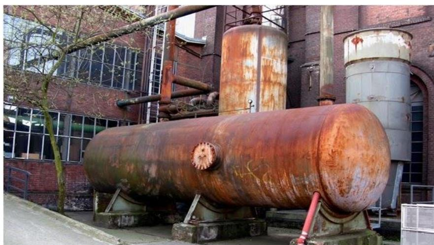
Slika 1. Opća korozija [6]
