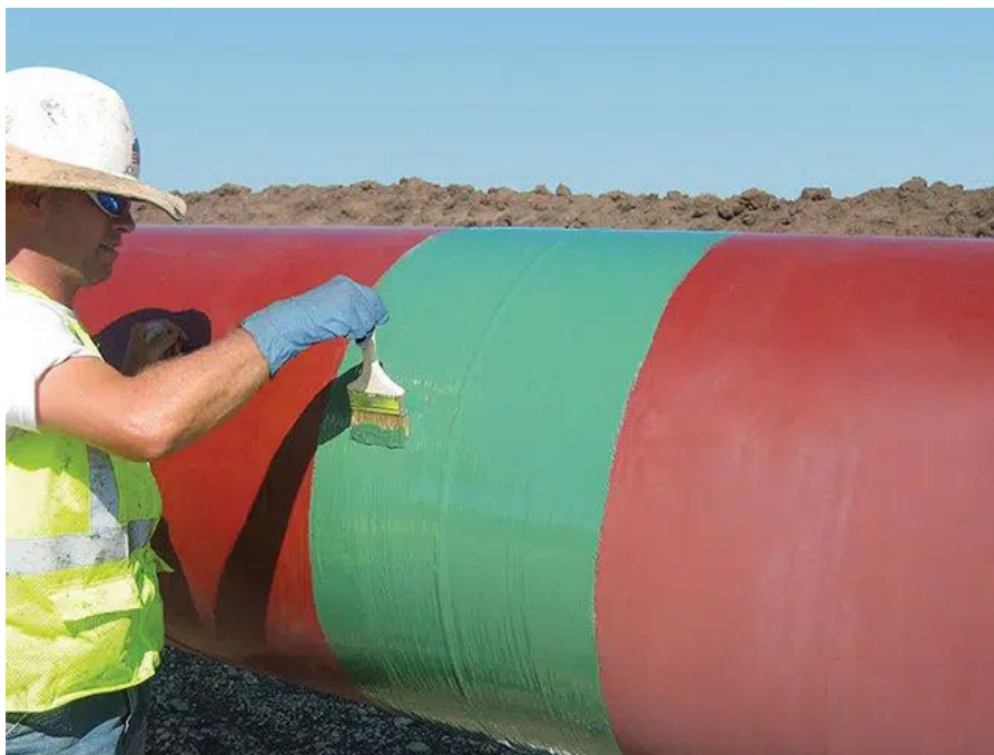
Slika 35. Ručno premazivanje površine [52]
