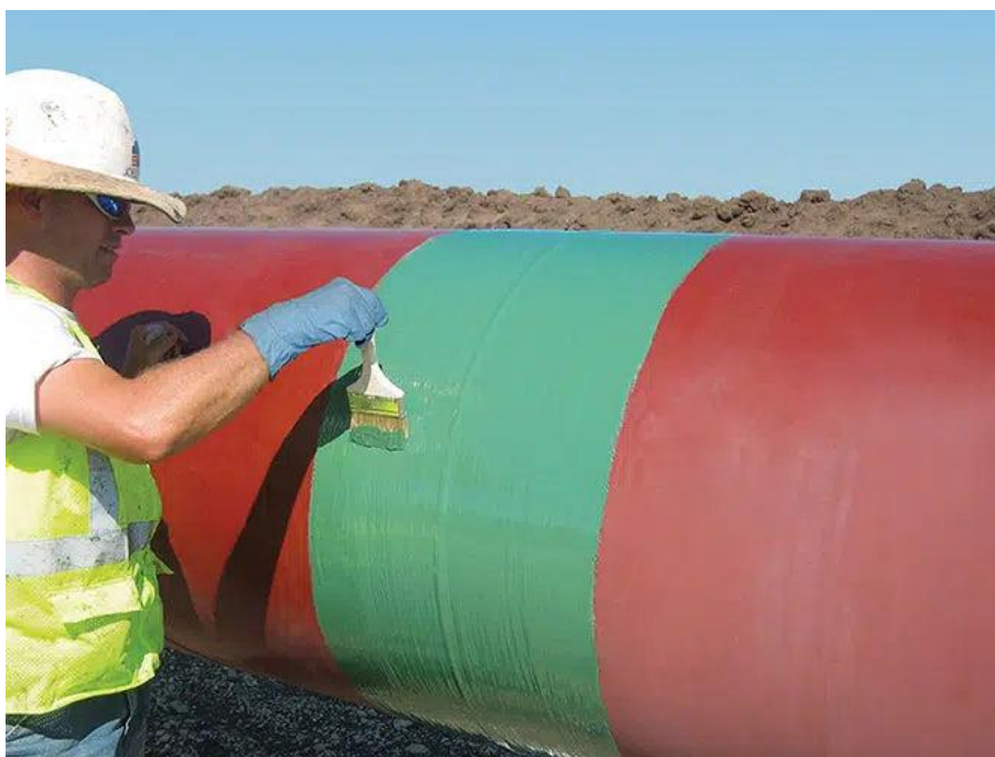
Slika 35. Ručno premazivanje površine [52]
