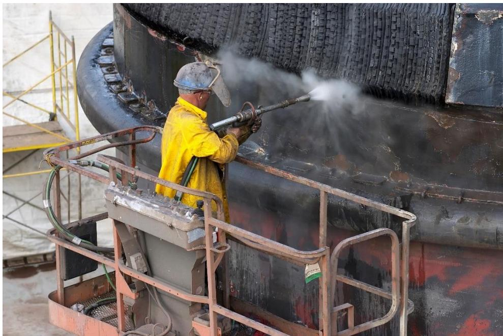
Slika 15. Priprema površine visokotlačnim vodenim mlazom [26]
