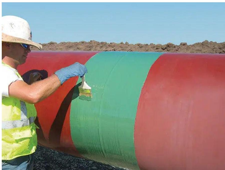
Slika 35. Ručno premazivanje površine [52]
