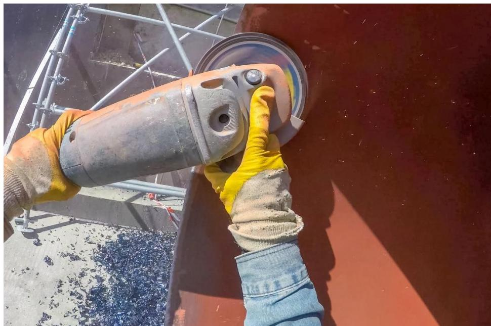
Slika 14. Čišćenje površine rotacijskom četkom [26]
