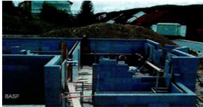
Slika 3.13. Učinkovita gradnja s blokovima od PS-E-a 28
