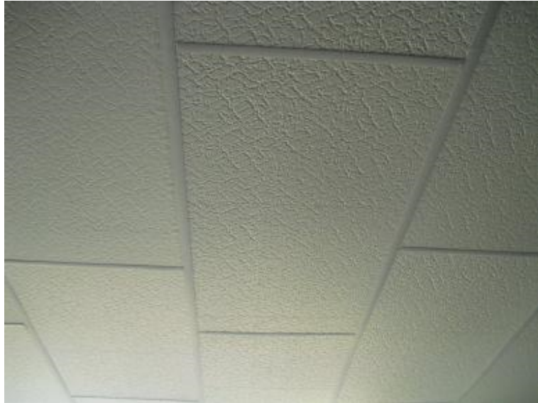
Slika 3.11. PS-E blokovi laminirani filmom od PVC-a 25
