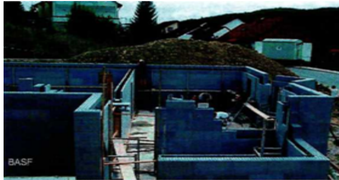
Slika 3.13. Učinkovita gradnja s blokovima od PS-E-a 28
