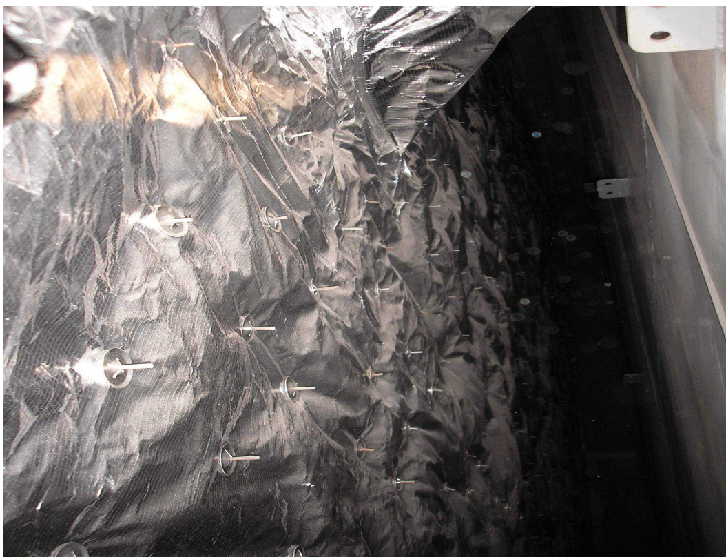
Slika 62 Izolacijski slojevi sa stezačima
