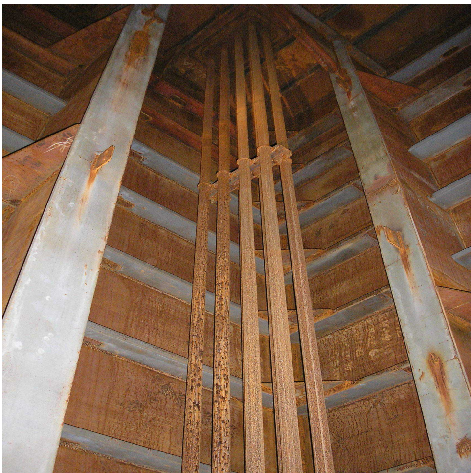
Slika 66 Fotografija ulaznih i izlaznih grana cjevovoda grijanja
