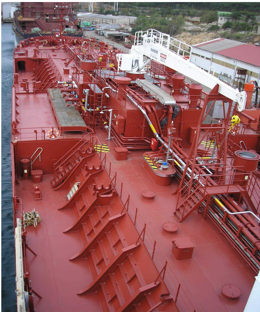
Slika 90 Nadvišena paluba s kućicom pumpne stanice
