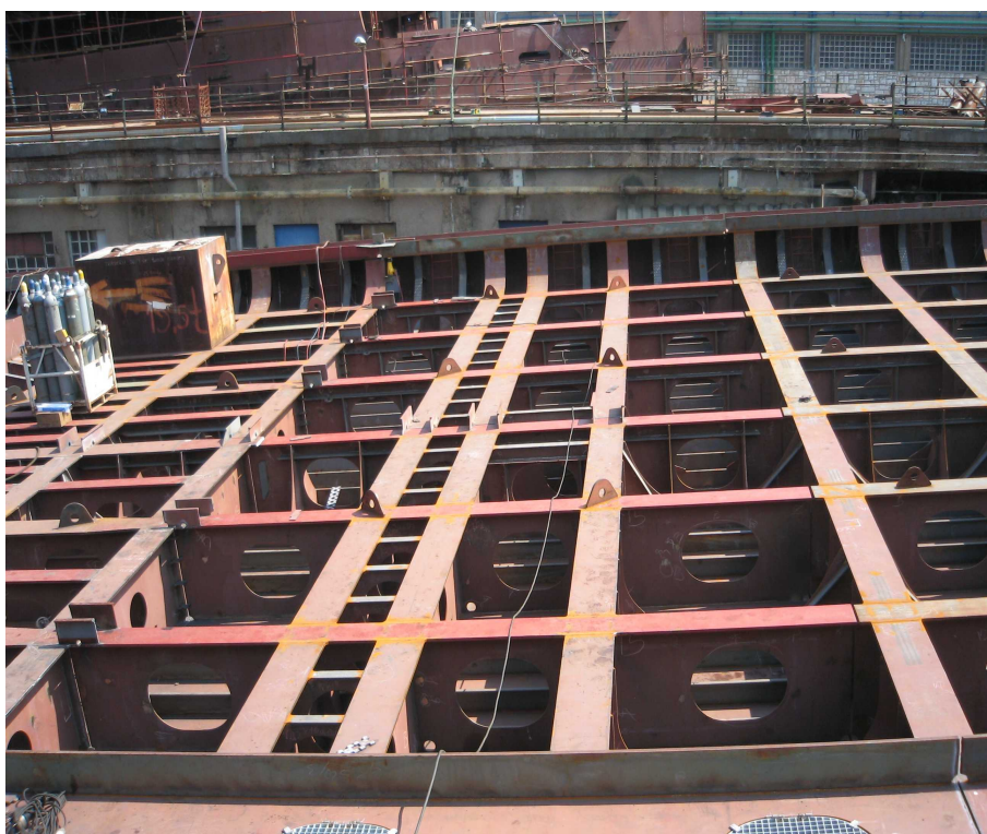
Slika x Struktura dna trupa broda za smještaj bloka spremnika 2 i 3.
