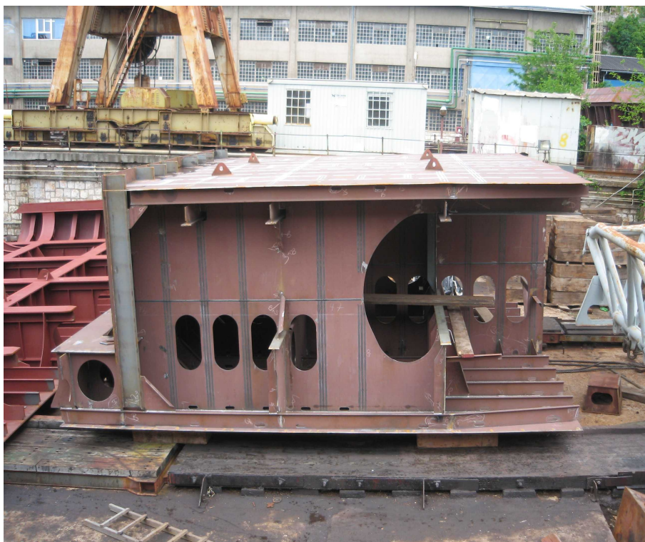
Slika 7 Povišen temelj strukture dna trupa za smještaj bloka spremnika 1 Blokovi spremnika 2 i 3 bit će postavljeni na strukturu dna trupa prema slici 8
