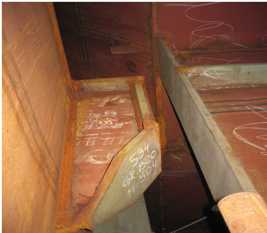
Slika 40 Protunaplavni ključ na strani opločenja strukture spremnika
