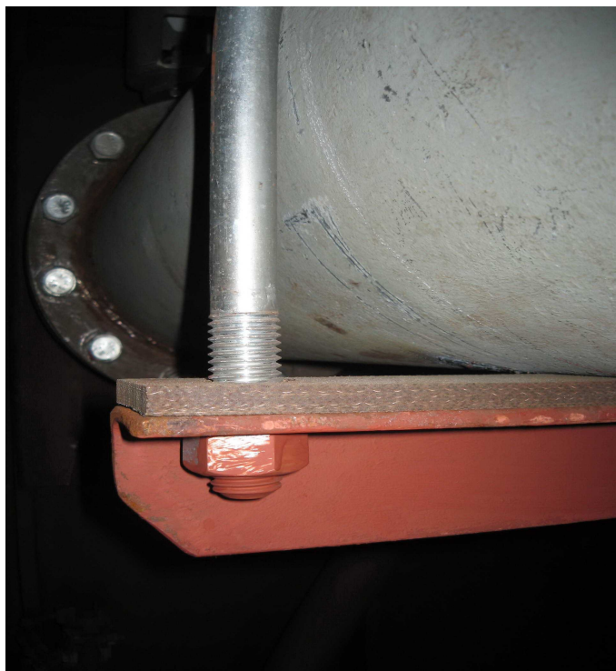
Slika 96 Fiksna objumica cijevi tereta
