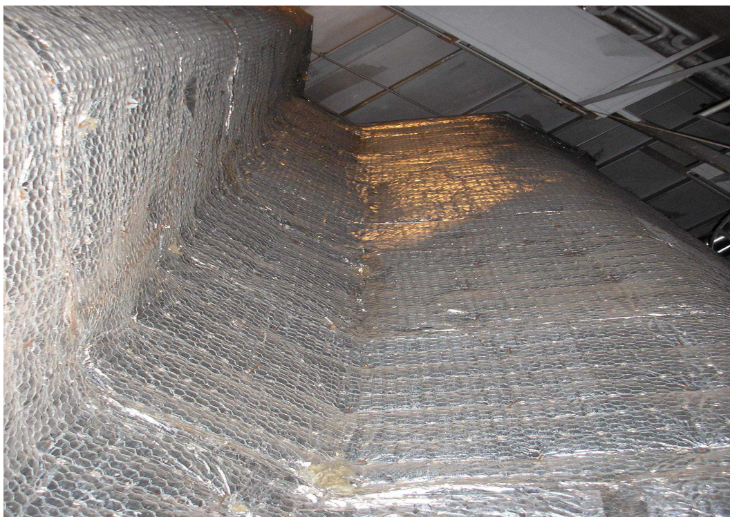
Slika 61 Izolacija s prikazom korugacije (naboranosti)
