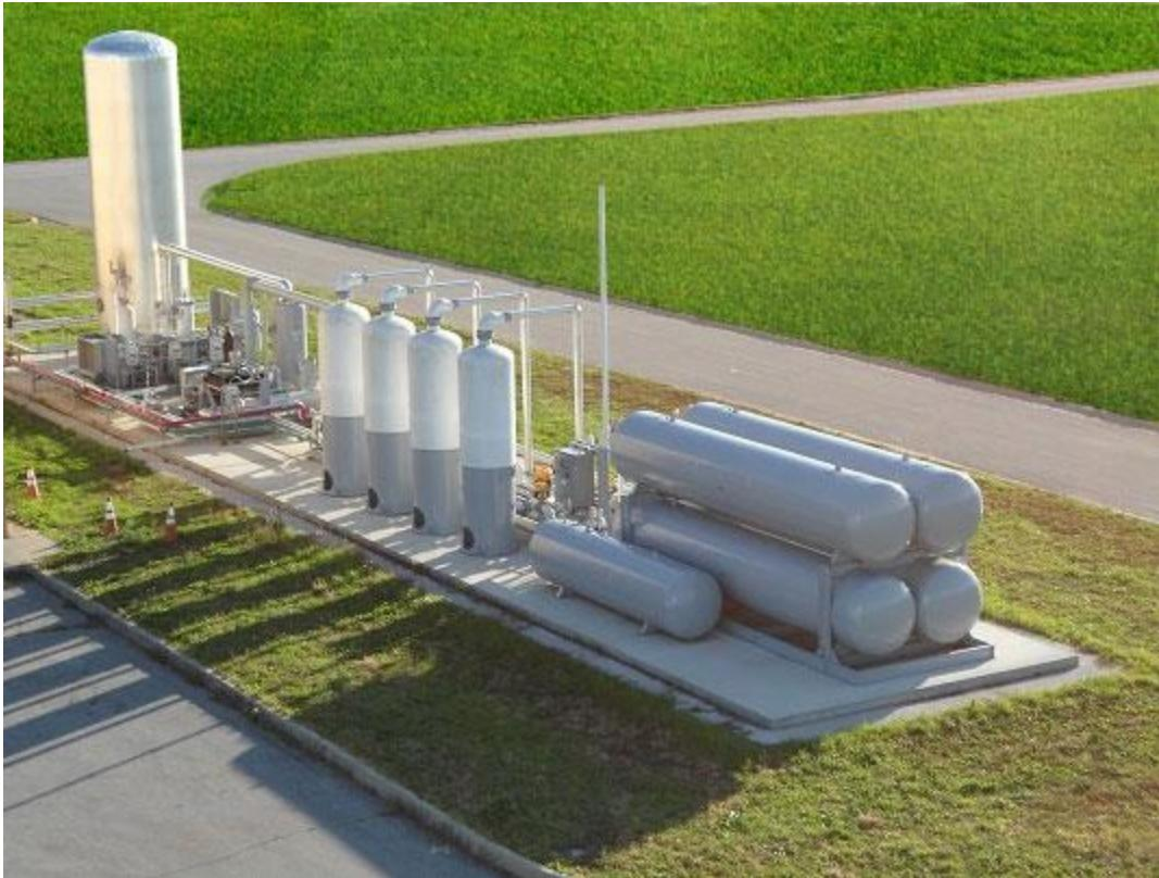
Slika 5: Postrojenje za pročišćivanje bioplina uz pomoć PSA tehnologije [23]
