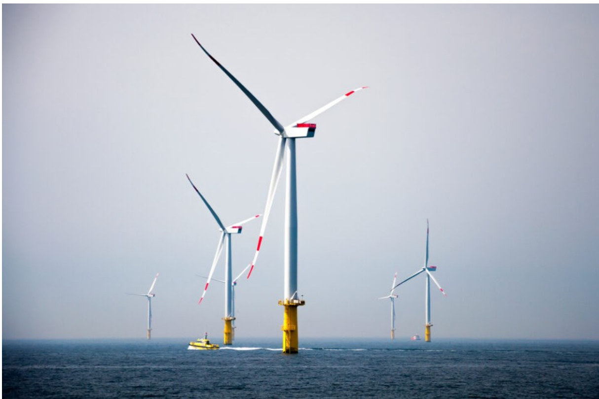
Slika 1. Vjetroelektrane na pučini mora
