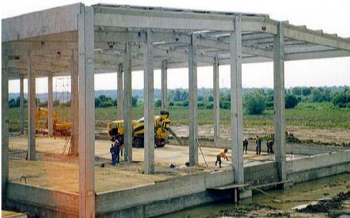
Slika 02: Građevinski radovi hladnjače
