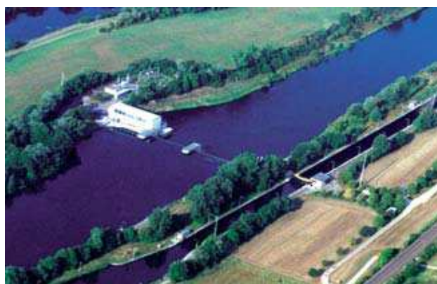
Slika 4.3: Ottendorf, Germany - zaštitna vrata za punjenje i pražnjenje odvodnog kanala
