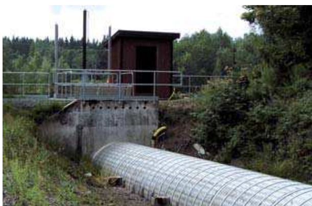
Slika 4.4: Bångbro, Sweden - kontrola dovoda vode na turbinu
