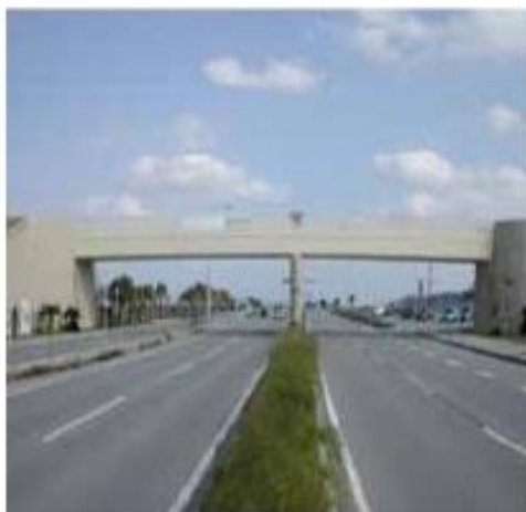
Slika 15. Pješački most u Okinawi (Japan) napravljen od hibridnog kompozitnog materijala [16]
