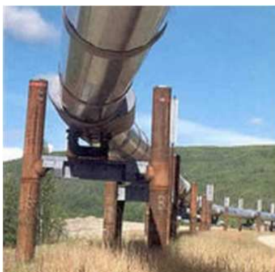
Slika 1. Nadzemni cjevovod, [1]
