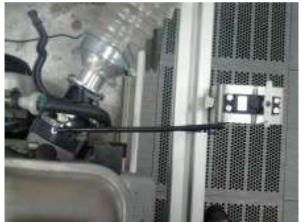
Slika 6.4. Spajanje serva sa zaklopkom
