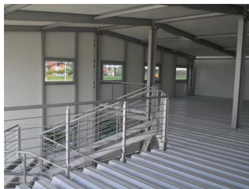
Slika 7. Sekundarna krovna konstrukcija. Slika 8. Paneli oslonjeni na IPE i cijevne profile.
