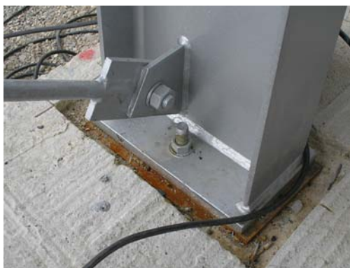
Slika 18. Detalj spoja konstrukcije i temelja.
