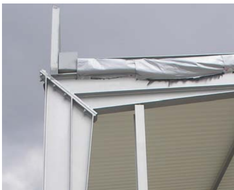
Slika 41. Detalj spoja stupova i greda.
