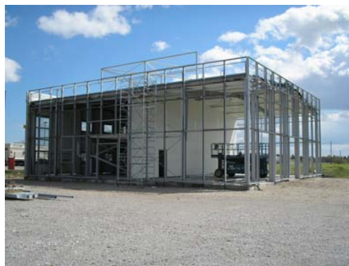
Slika 1. Čelična konstrukcija u AutoCAD-u [1]. Slika 2. Konstrukcija tijekom montaže.
