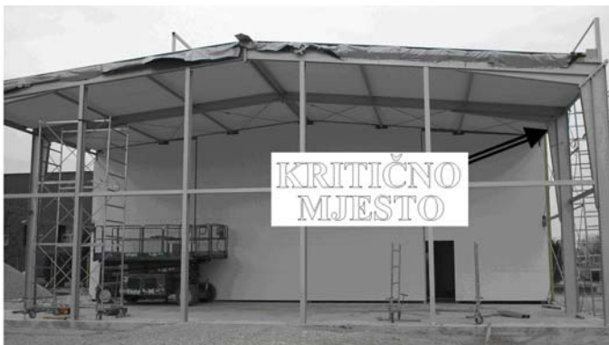
Slika 13. Položaj mjesta kritičnog naprezanja.
