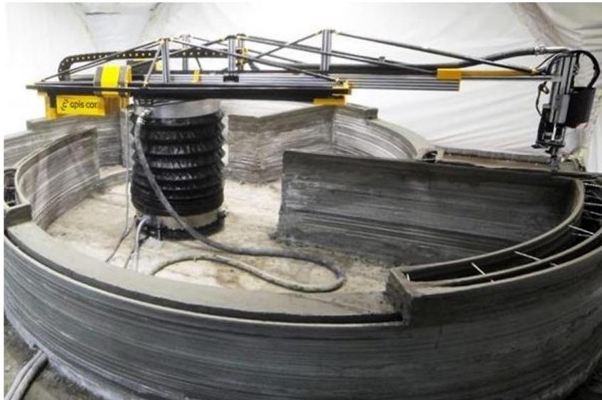
Slika 6 Polarna izvedba 3D printera za gradevine [8]
