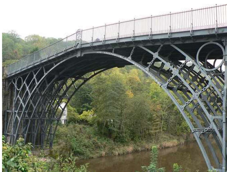
Slika 1. Prvi most izrađen od željeznog lijeva [1]
