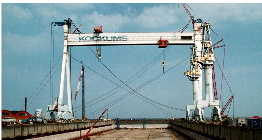
Slika 1. Portalna dizalica velikih nosivosti Kockums “Tears of Malmö”
